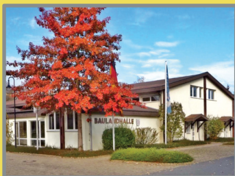
Baulandhalle (Ausweichort) Kapellenstraße 14 74706 Osterburken
