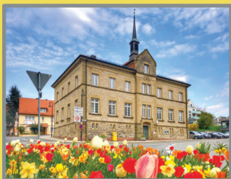
Alte Schule Turmstraße 25 74706 Osterburken
