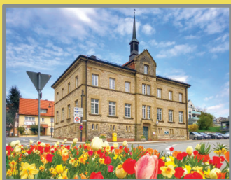
Alte Schule Turmstraße 25 74706 Osterburken
